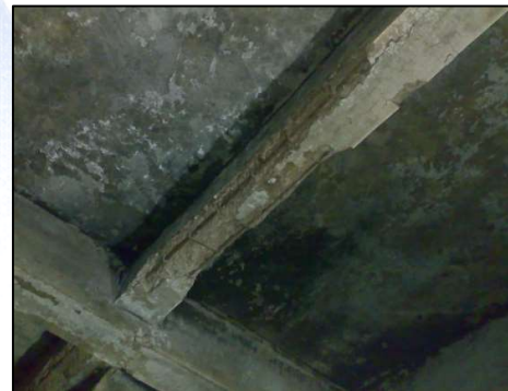
Gambar 6: Cacat beton spalling , yaitu pengelupasan pada selimut beton akibat korosi pada tulangan.
