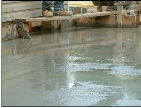
Gambar 5: Cacat beton bleeding , yaitu penguapan yang terjadi pada beton segar akibat penusukan yang berlebihan.
