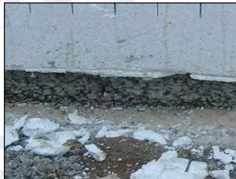
Gambar 7: Campuran beton yang mengalami segregasi, yaitu pemisahan agregat kasar dengan agregat halus.
