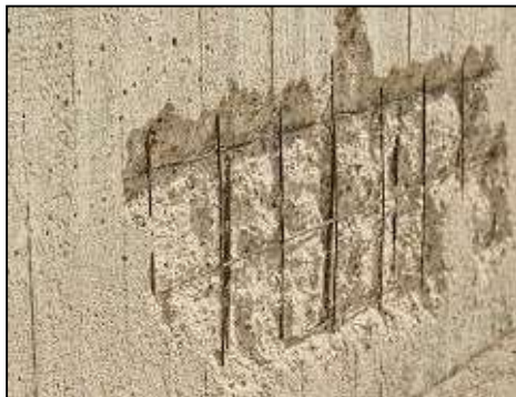
Gambar 6: Cacat beton spalling , yaitu pengelupasan pada selimut beton akibat korosi pada tulangan.
