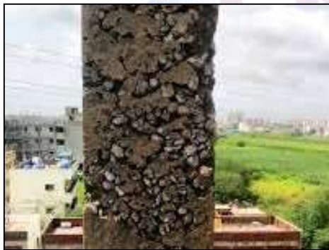
Gambar 7: Campuran beton yang mengalami segregasi, yaitu pemisahan agregat kasar dengan agregat halus.
